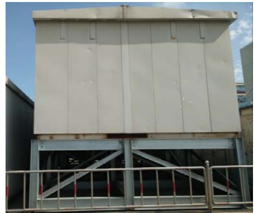
图4 装配式钢结构基础实物照片
